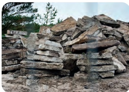
Begonnen wurde mit dem Rückbau des 400 Meter langen Plattenweges, der zum Rundwanderweg führt. Im Nothafen warteten die in kleinere Segmente zerlegten Platten auf den seeseitigen Abtransport zum Recyceln nach Barth.
